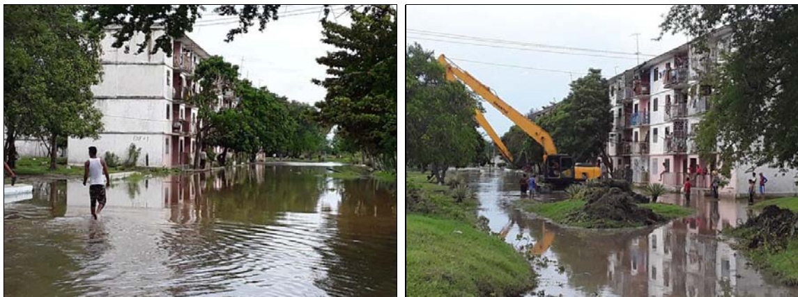
Inondation à Vado del Yeso, Granma
