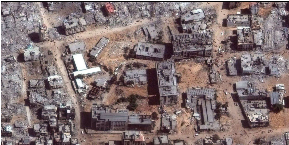
Hôpital al-Chifa et quartier environnant, 1er avril 2024
