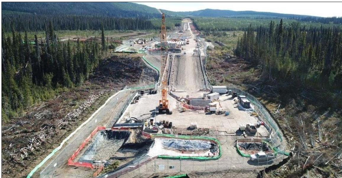
**Plateforme de forage construite par Coastal GasLink pour forer sous le cours supérieur de la Wedzin Kwa, 18 septembre 2022**
