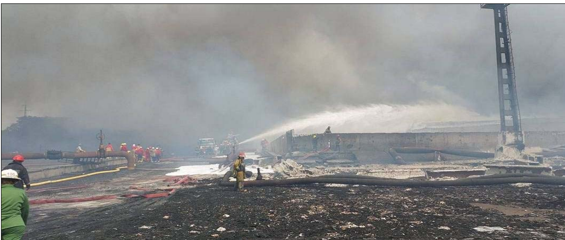
Les forces cubaines, ainsi que le personnel de la PDVSA et de PEMEX, utilisent de l'eau et de la mousse sur les restes du quatrième réservoir, le 10 août 2022.
