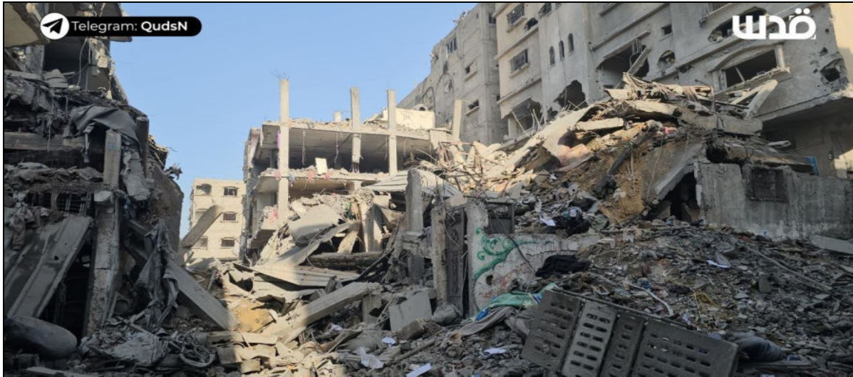
Destruction laissée par le massacre israélien perpétré à Beit Lahiya dans le nord de Gaza, 28-29 octobre 2024
