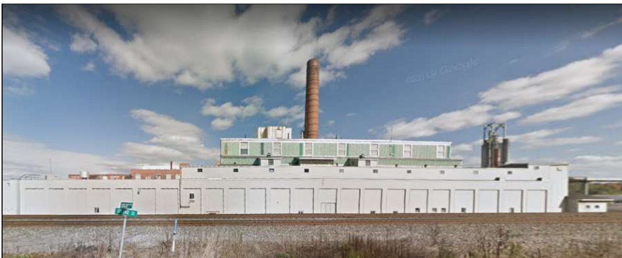
Usine de Morton Salt à Silver Springs, New York
